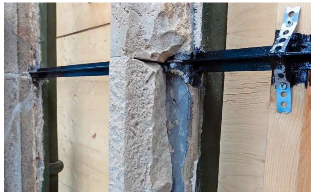
Een van de afgebrokkelde raamstijlen, de aanleiding voor de restauratie.
