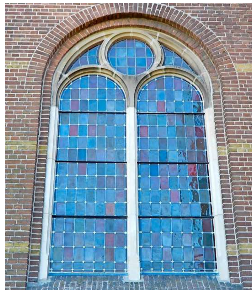
Een van de voltooide, zeer karakteristieke ruitjesramen, strak in nieuw lood. De raamstijlen zijn nieuw, de tracering erboven is gerestaureerd.
