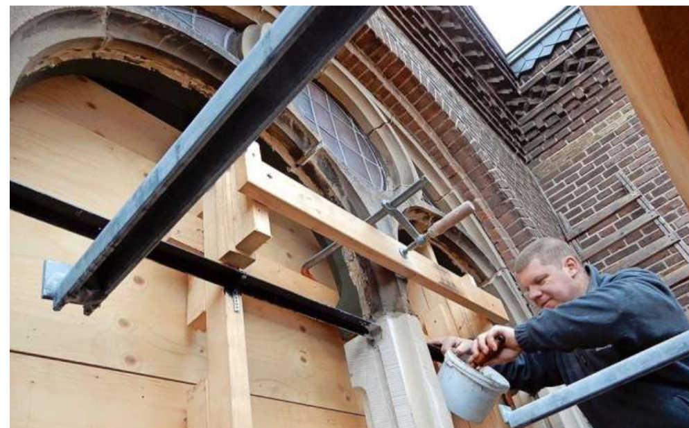
Een van de bouwvakkers bezig met het voegen van naden.
