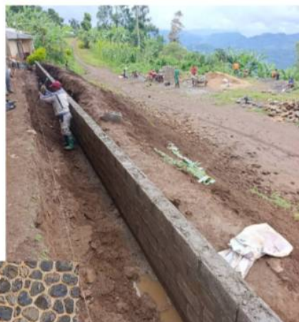
Hierboven: het werken aan de goot voor waterafvoer.
